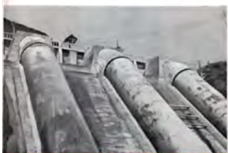
Cámara de carga y colector de hierro.
