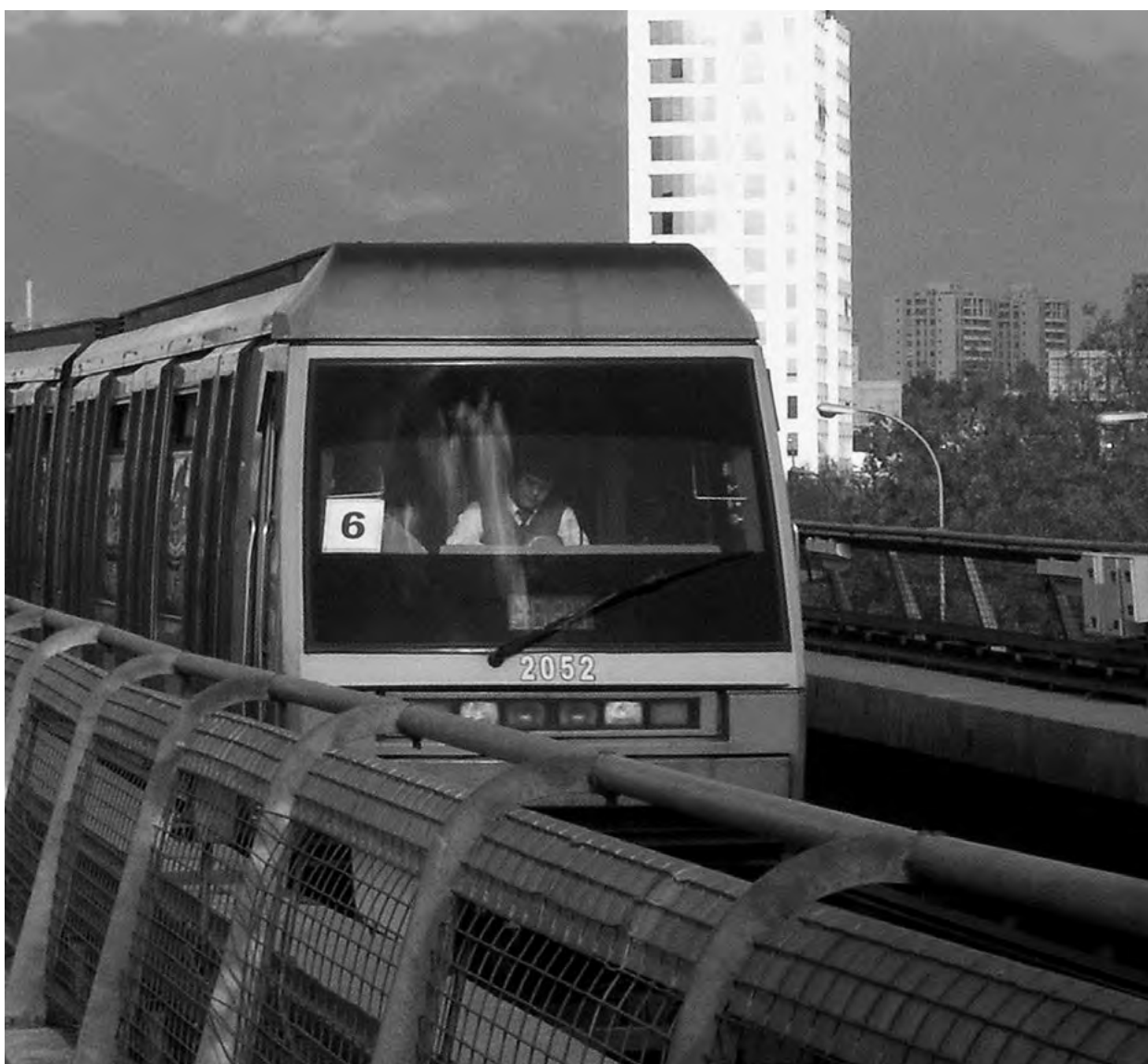
Viaducto elevado línea 5 Metro de Santiago, altura estación Mirador. / Elevated viaduct Metro de Santiago line 5, near Mirador station. ©Ariel Cruz / Creative Commons
